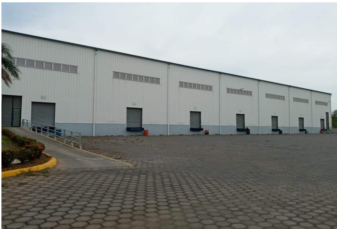
Ilustración 27: Almacén N° 4 “Almacenedora Lafise”
