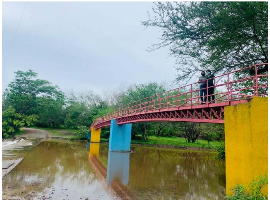
Ilustración 33 Puente peatonal Las Pilas
