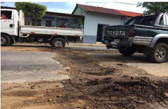
Ilustración 5: Relleno de tierra
