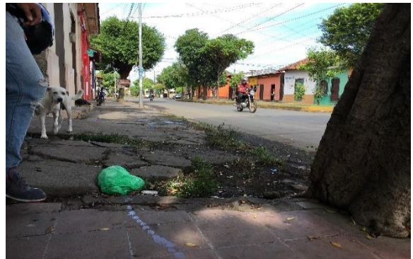
Ilustración 30: Acera en mal estado (BU)
