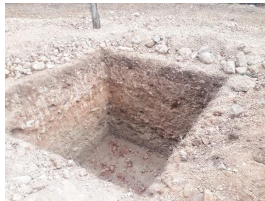
Figura 55 Iniciación de Construcción de sumidero
