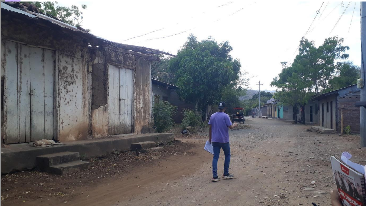
Figura 68 Calle No.3 Zona 2 – Actualmente sin revestimiento.
