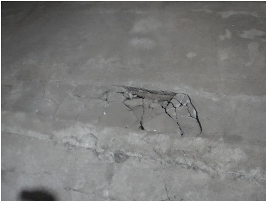
Figura 19 Evidencia 3.2.2 Estructuras internas, Pisos
