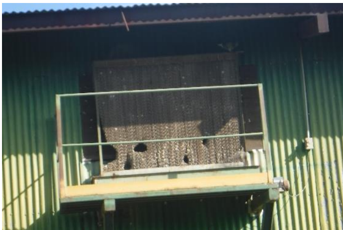
Figura 25 Evidencia Numeral 6. Mantenimiento y Saneamiento
