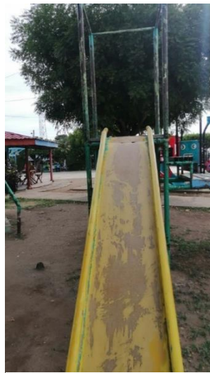
Figura 225: Oxido en resbaladero.
