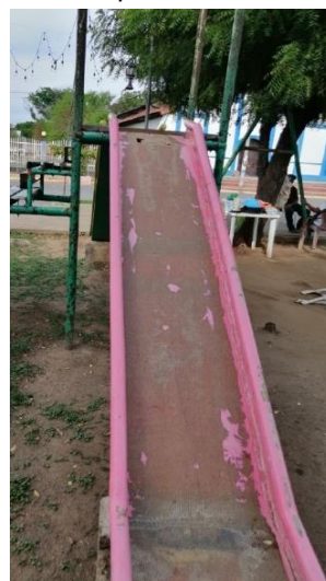
Figura 228: Oxido y Descascamiento de pintura
