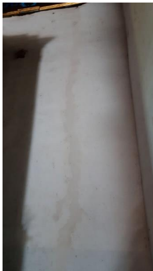
Figura 146: Esgurrimiento del Caleo.
