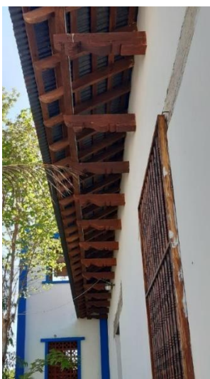
Figura 144: Estructura de madera alero sur.
