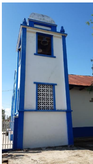
Figura 137: Exterior del Campanario.
