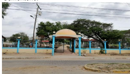
Figura 183: Vista frontal Cementerio.
