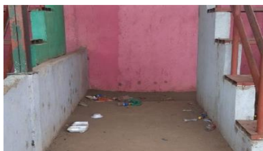
Figura 71: Pasillo entre graderías de estadio de Beisbol.
