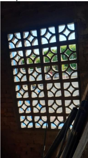
Figura 141: Celosía en pared de campanario.
