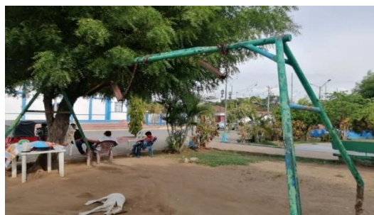
Figura 219: Deterioro de chinos, decoloración y presencia de oxido.
