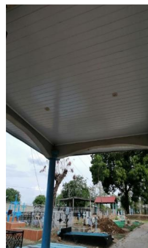
Figura 185: Cielo falso de PVC
