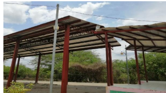
Figura 167: Estructura metálica de protección.
