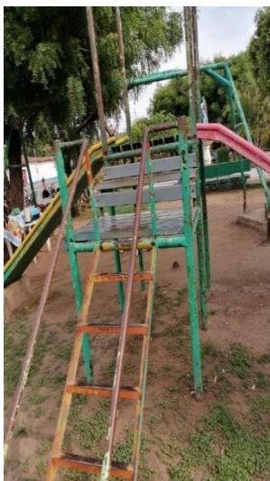
Figura 230: Descascamiento de pintura y oxido en juego infantil.
