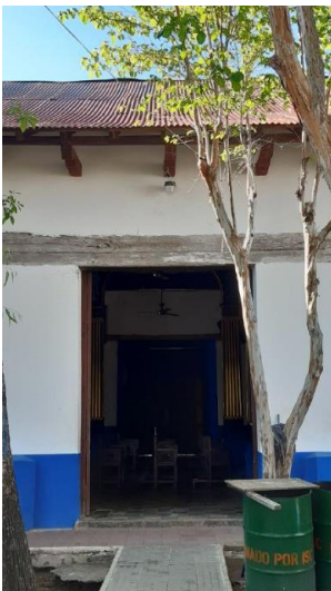
Figura 123: Vista de fachada sur.
