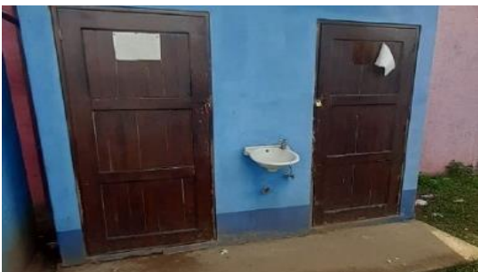
Figura 68: Servicios sanitarios de Estadio de Béisbol
