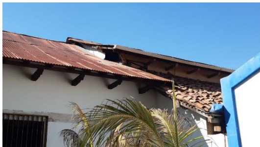
Figura 155: Vista cubierta de techo.
