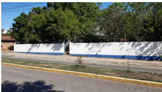
Figura 17: Muro perimetral de Escuela Primaria.
