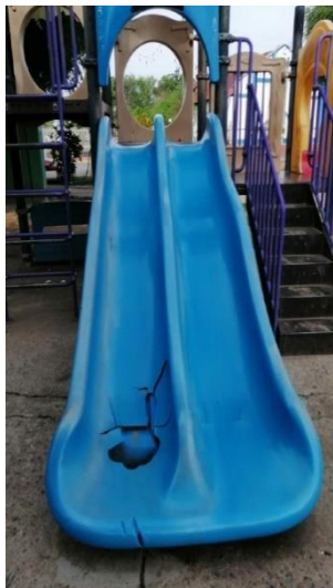
Figura 226: Grietas en resbaladero.
