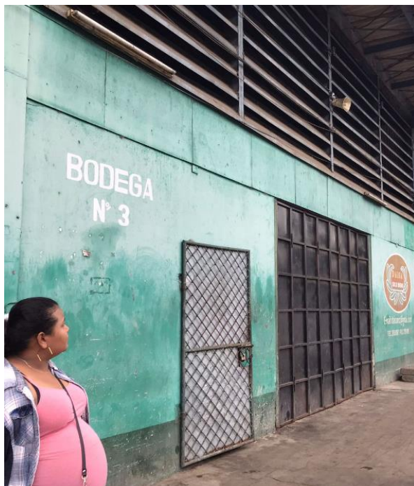
Anexo 20: Foto-Entrada al área de almacén
