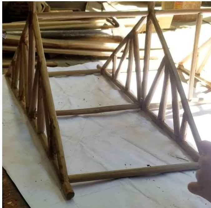
Anexo 11: Fijación de las cerchas con regla de madera y vigas permanentes
