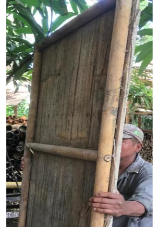
Figura 15: Paredes esterillado + mortero (Fuente propia)
