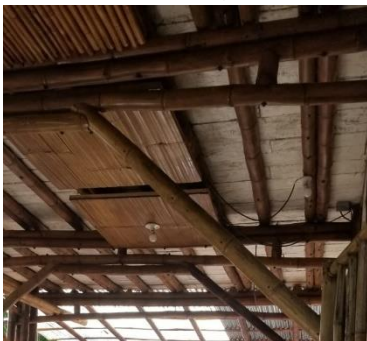
Figura 17: Vigas en Bambucen (Fuente propia)
