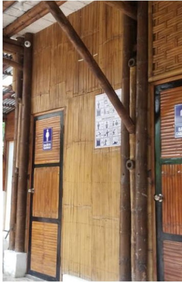
Figura 14: Paredes con esterillado de bambú (Fuente propia)
