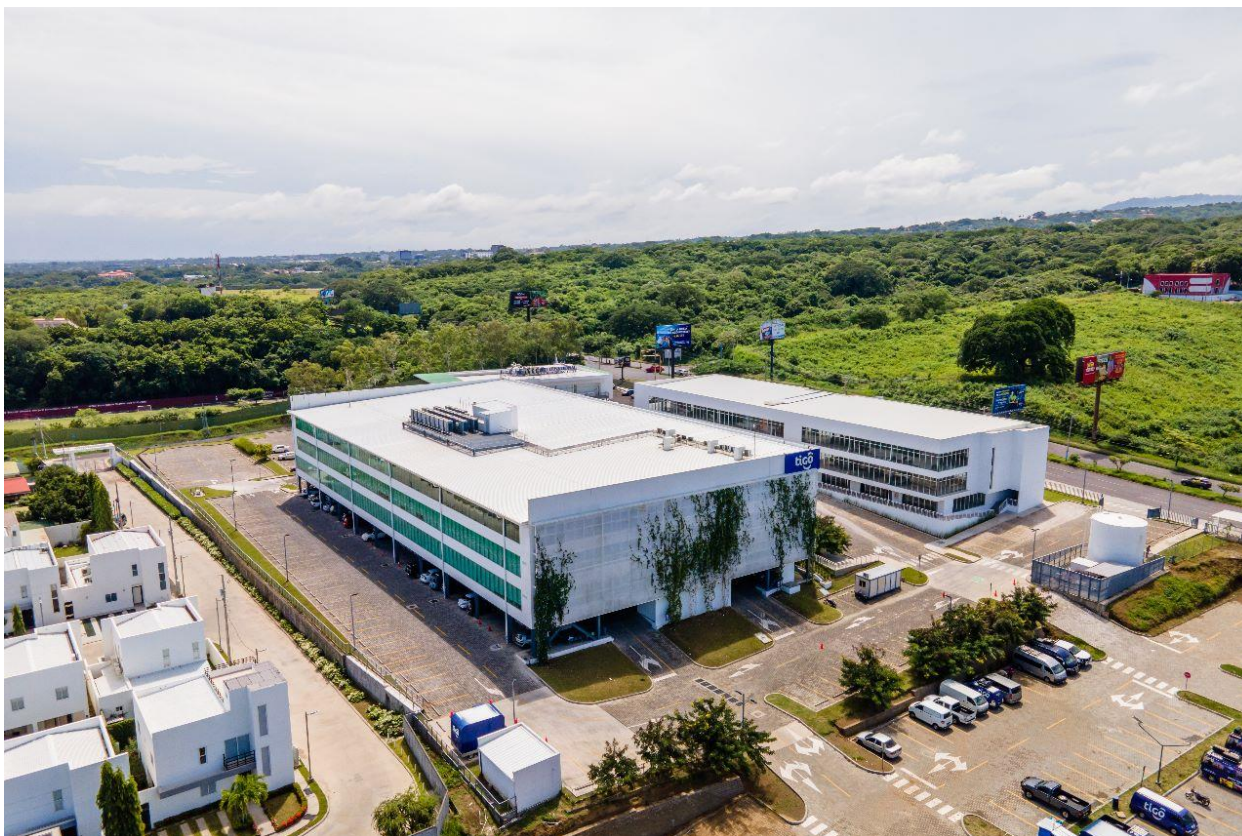
Área exterior de acceso al edificio
