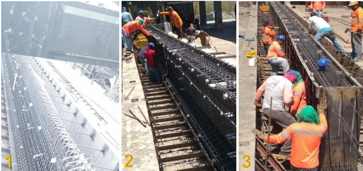
Ilustración 28. Colocación de segunda cara del molde.
