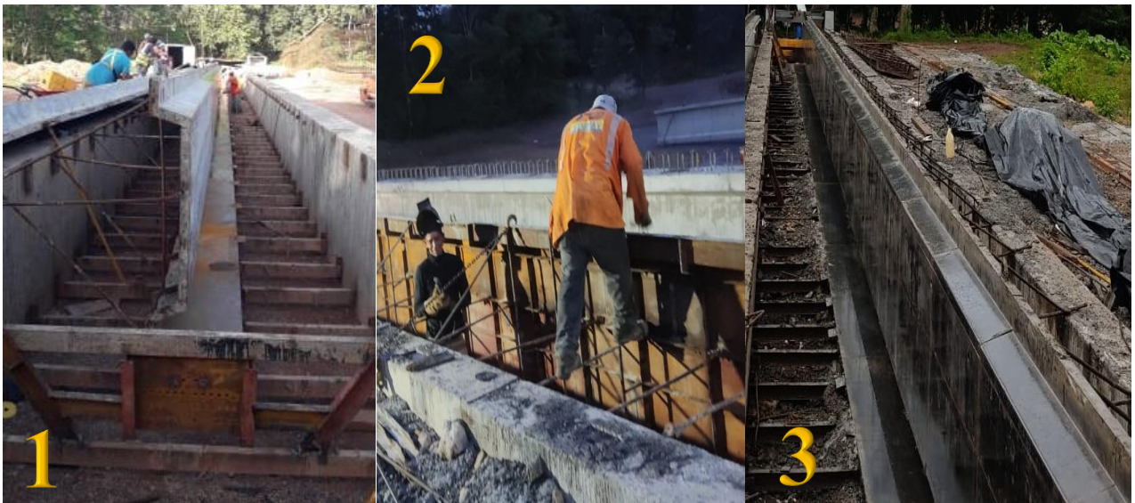
Ilustración 24. Colocación de primera cara de molde.
