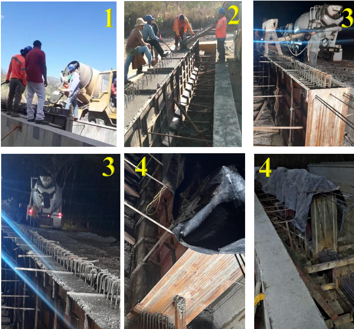
Ilustración 30. Proceso colado del concreto.
