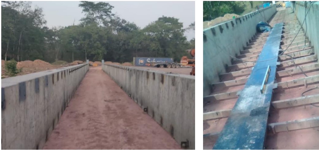
Ilustración 23. Instalación del Banco de Tensado.
