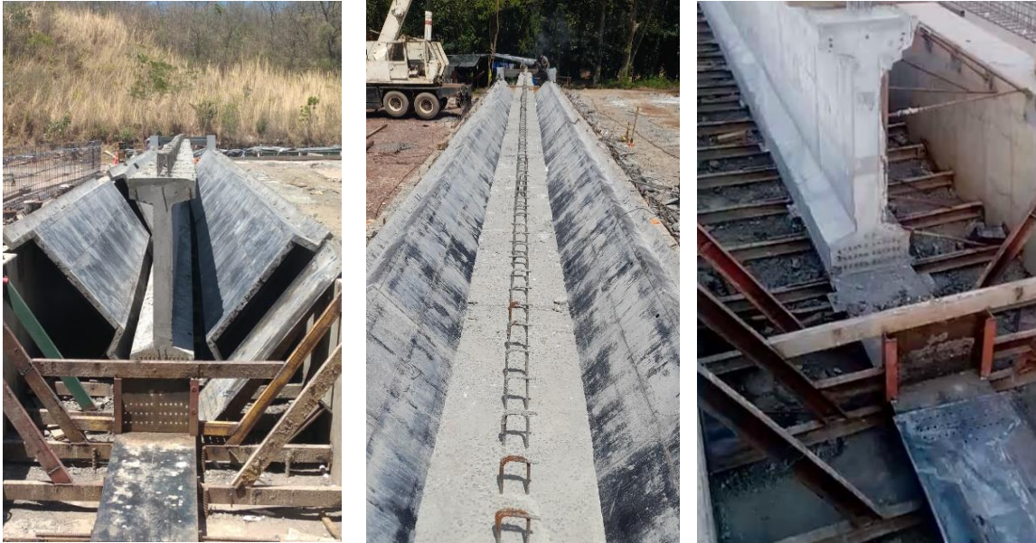
Ilustración 32. Desencofrado de Viga.
