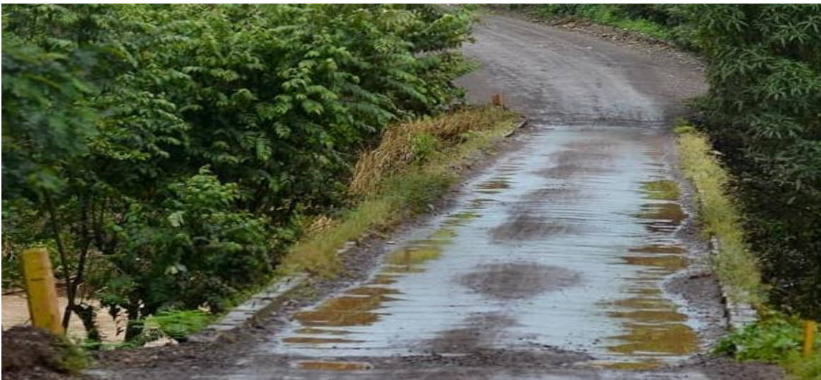
8 ILUSTRACIÓN 22. ANTIGUO PUENTE YAHOSKA.
