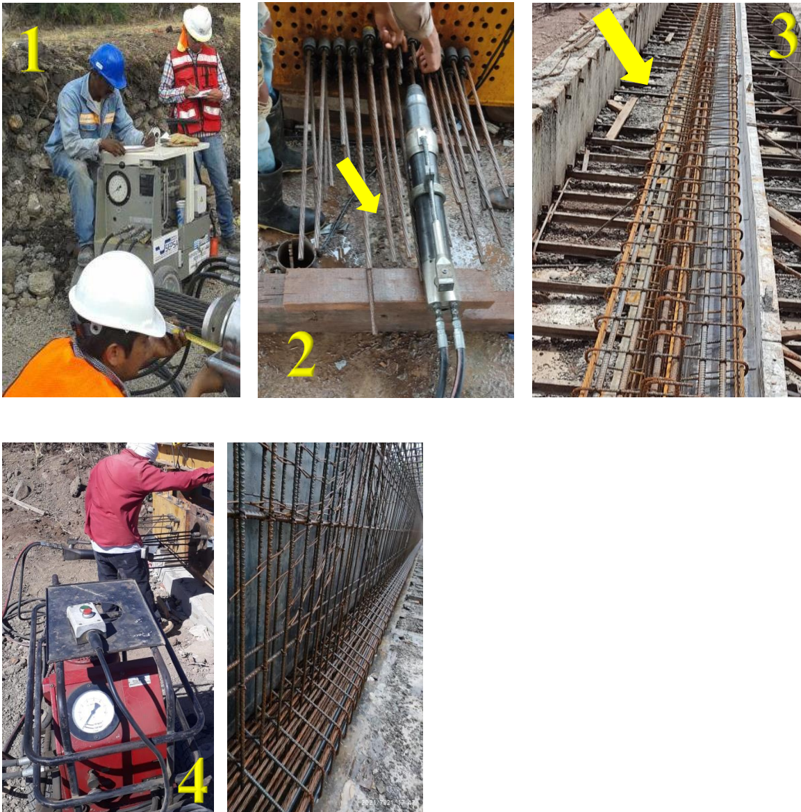
Ilustración 27. Momento de Tensado de Torones.
