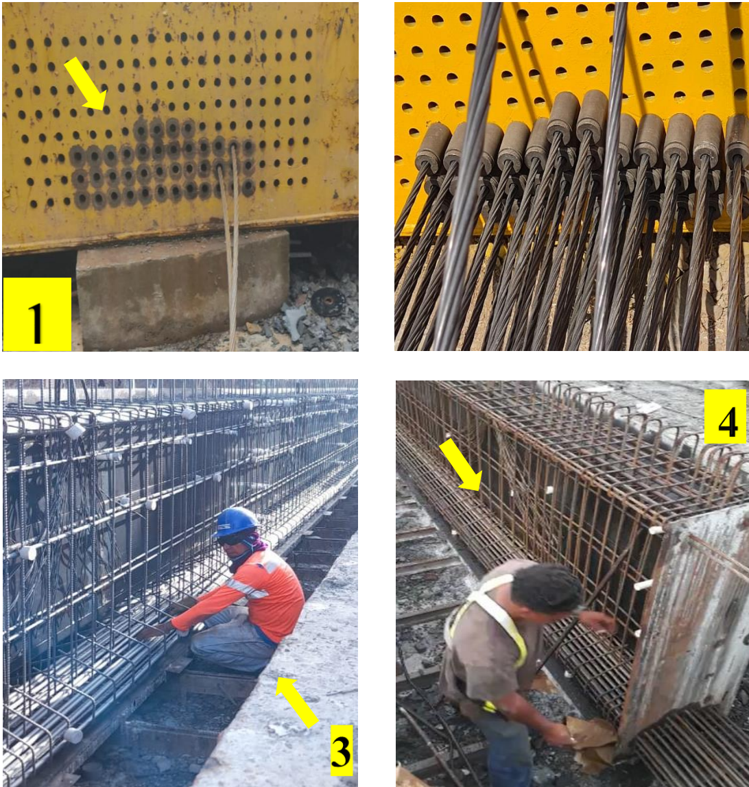
Ilustración 26. Colocación y verificación de torones.
