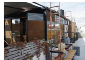
Desmontaje de fachada existente.
