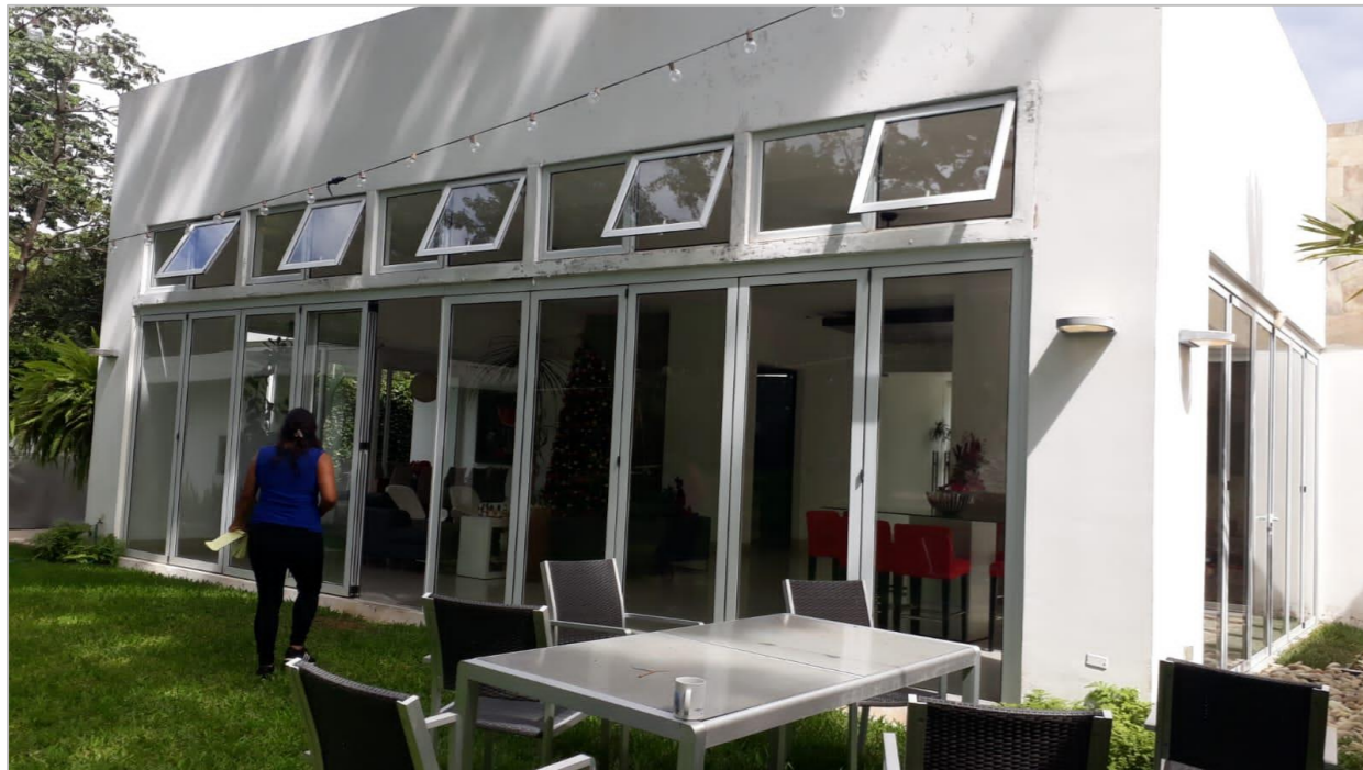
Nota. Muro cortina vista exterior, casa en Balcones de Santo Domingo, por Karen Urbina, 2022.
