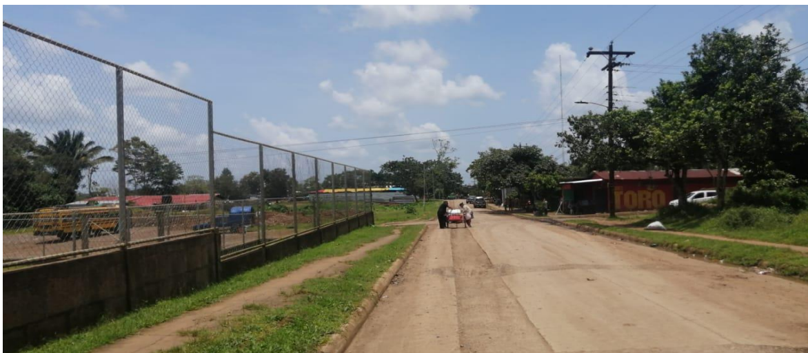
Ilustración 29 Instalaciones de Alcantarillado Sanitario Fuente: Propia
