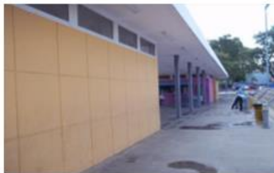
Instalaciones sanitarias, parque Luis Alfonso Velásquez Fuente: La prensa/ Managua Nicaragua 2012
