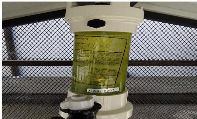
**Figura 2** Tubo de cloro para potabilización del agua de pozo
