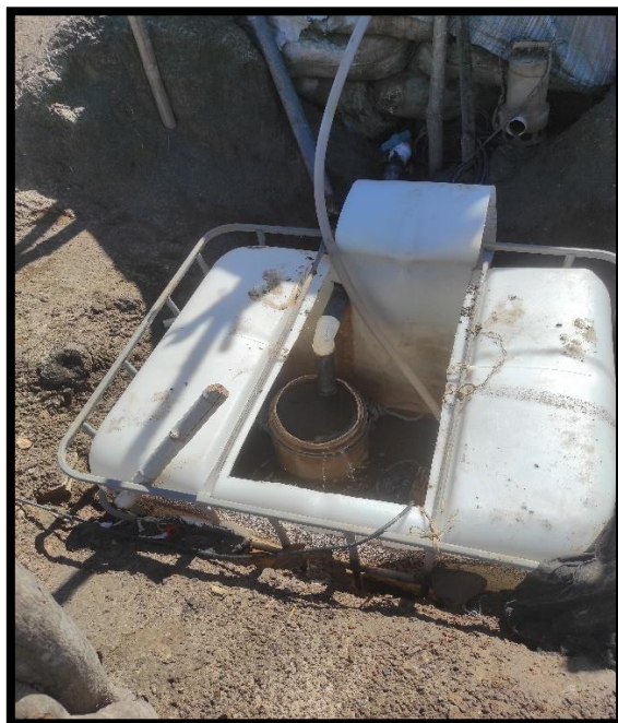
Figura 13. BIN de recirculación de agua
