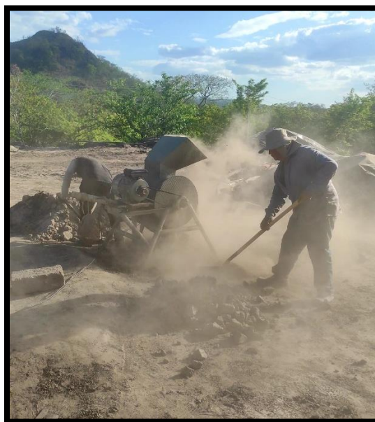
Figura 11. Pulverización de lodillo
