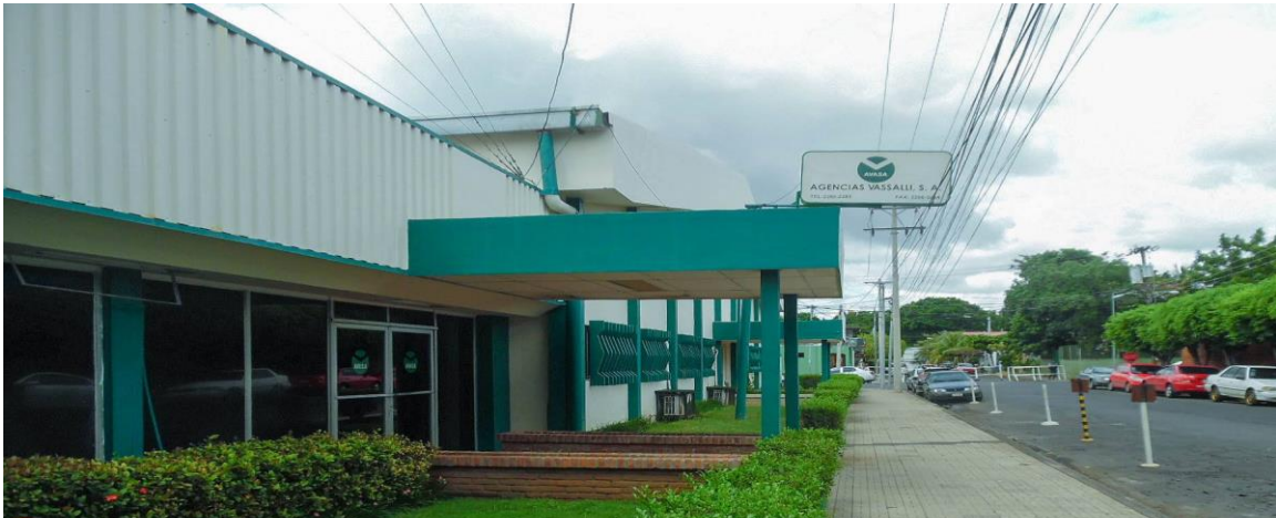
Imagen 2 Instalaciones de la empresa Agencias Vassalli, S.A.
