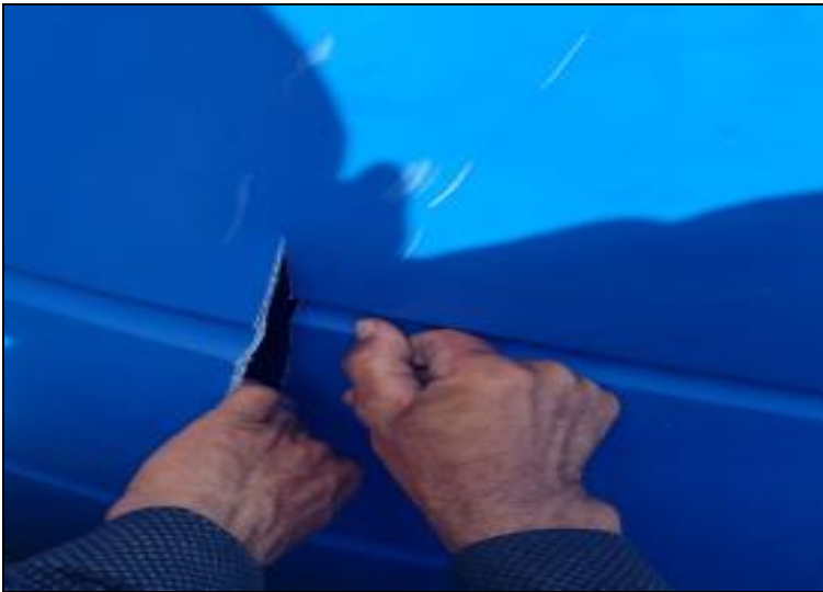
Figura 54. Inspección Tanque de Almacenamiento.
