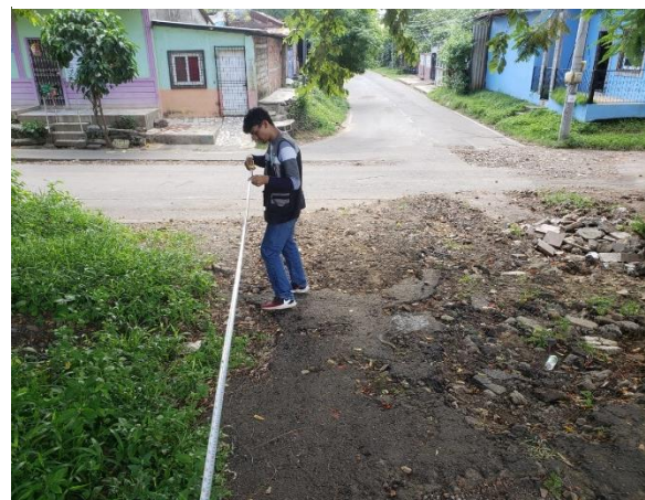
Figura 25: Apoyo en levantamiento topográfico
