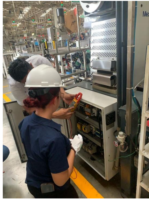
Figura 22. Medición de voltaje a las máquinas
