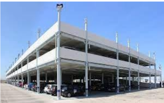
Figura 3 Edificio de aparcamiento
