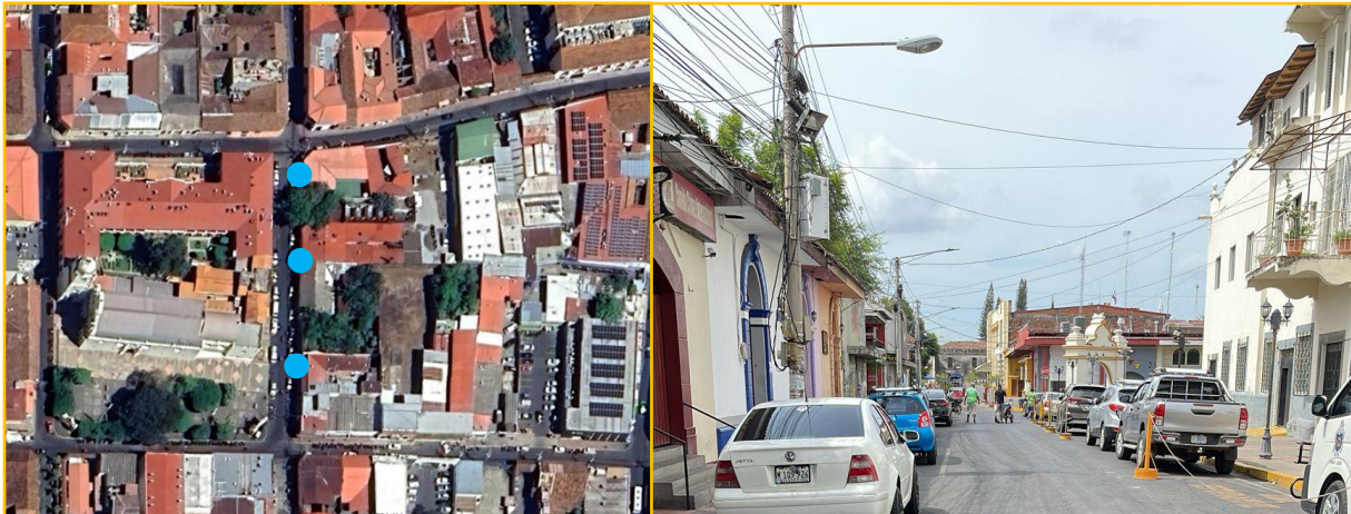
Figura 66 Ubicación de postes eléctricos.
