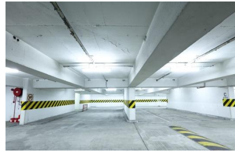
Figura 4 Edificio de aparcamiento
