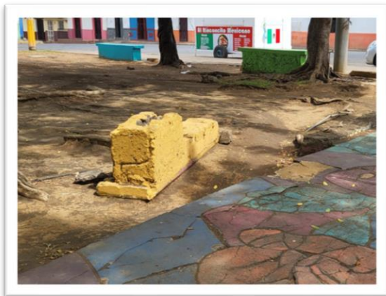
Figura 88 Mobiliario urbano en mal estado en el parque de Guadalupe.
