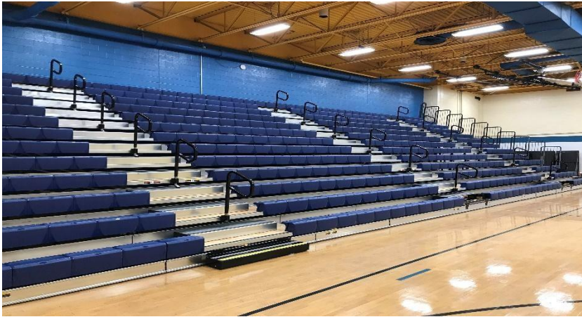
Figura 1 Gradas de cancha multiuso
