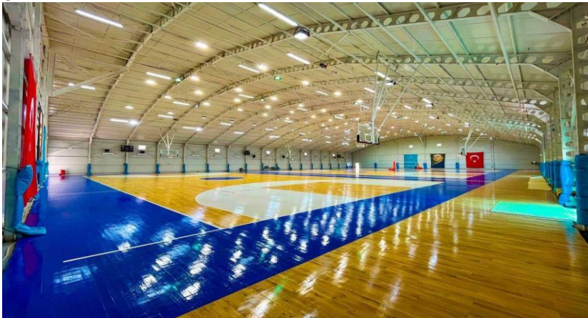
Figura 2 Sistema de iluminación
