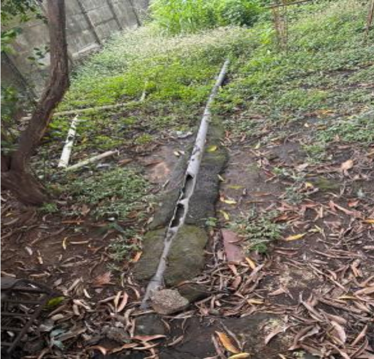
Figura Deterioro que presenta la tubería PVC
