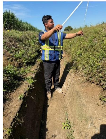
Figura 17 Medición de altura, presenta terreno irregular
