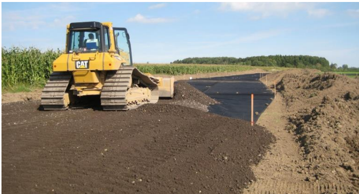
Figura 6 Mejoramiento de suelo.
