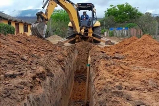
Figura 3 Movimiento de Tierra.
