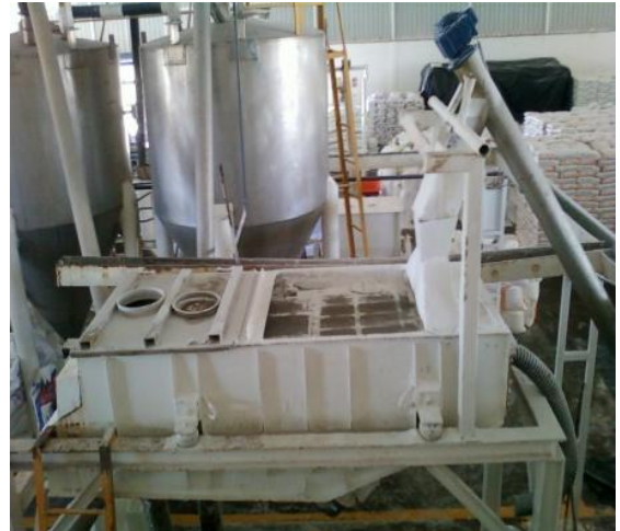
Anexo 25 Silos de almacenamiento
