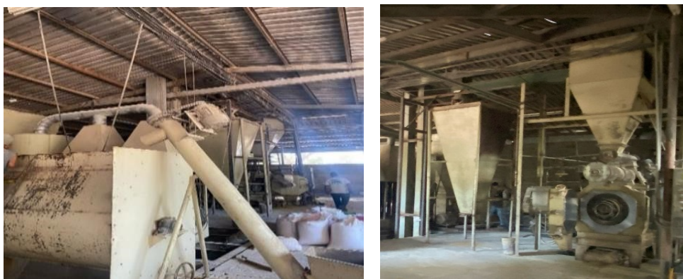
Figura 8 Maquinaria utilizada en el proceso de molienda y mezclado
