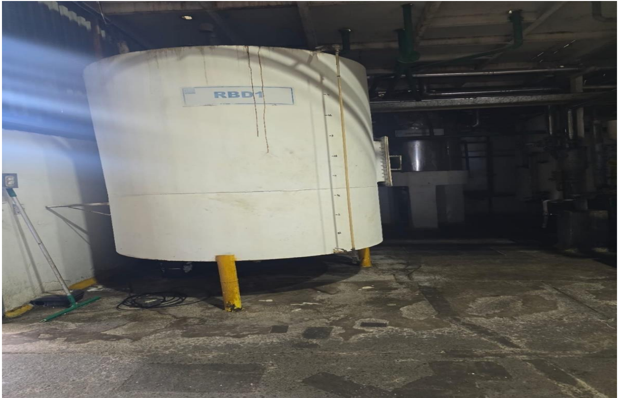
Tanque de almacenamiento de aceite terminado
