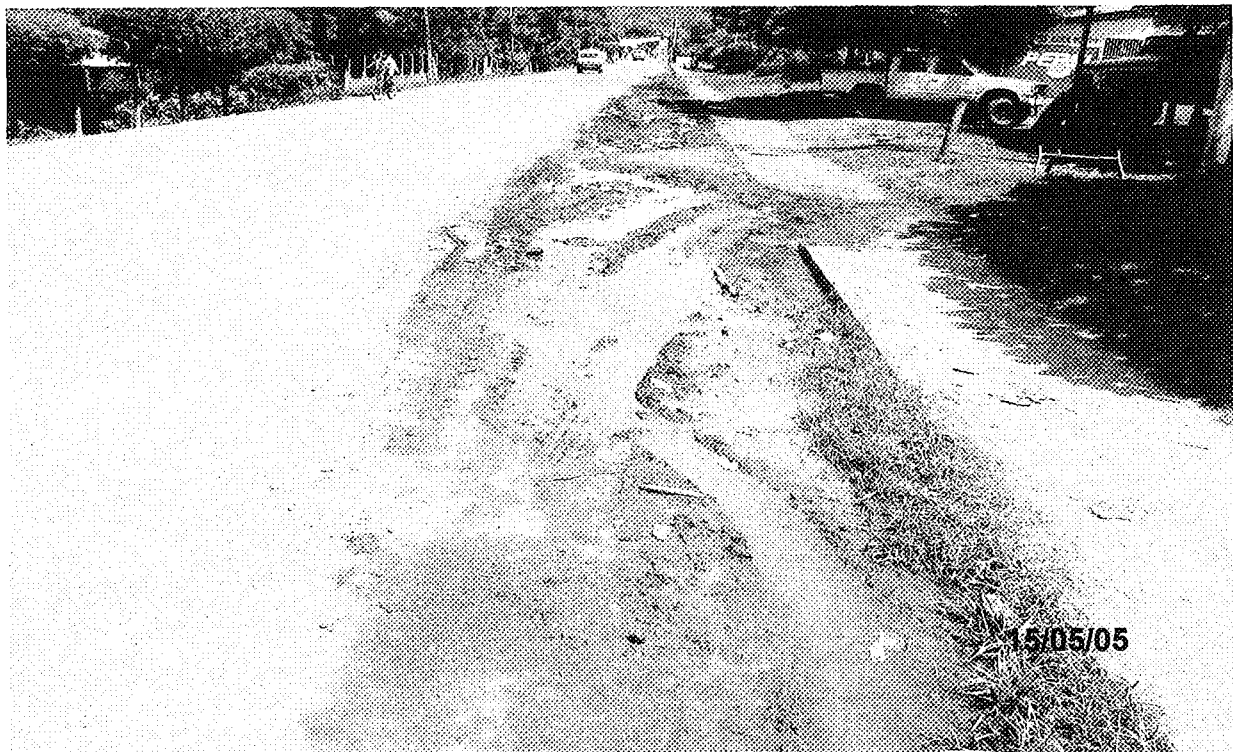
5.2. Desde el punto estético podemos observar el daño a la principal vía de acceso de Tola, producto del vertido inadecuado de aguas grises.
