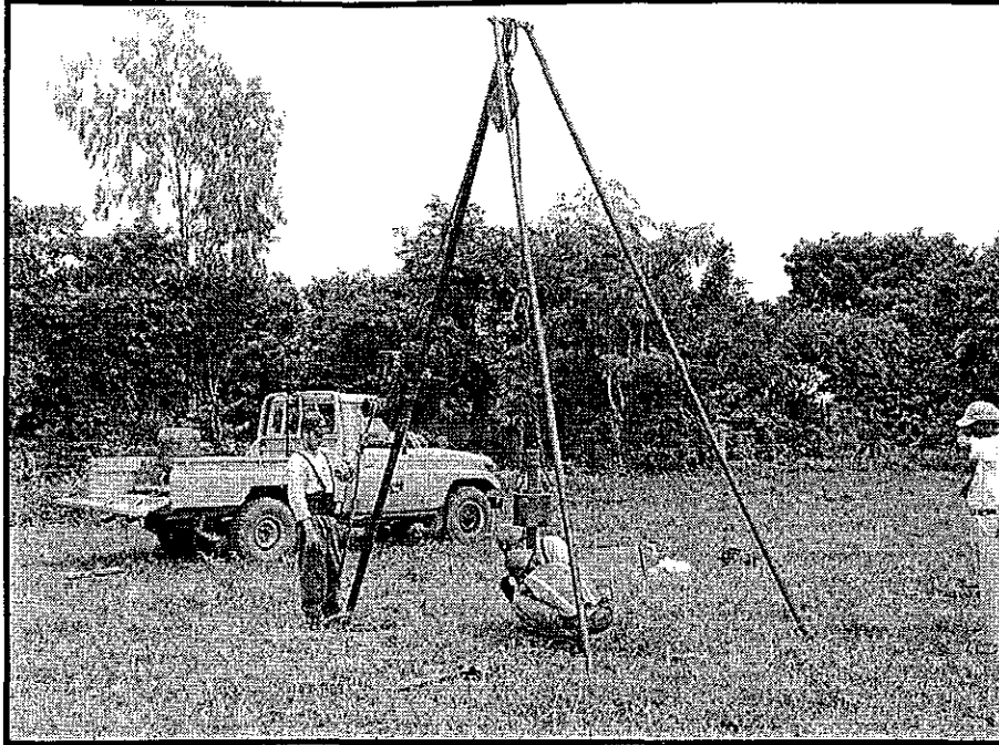
Fotografía 2 Perforando a Percusión
